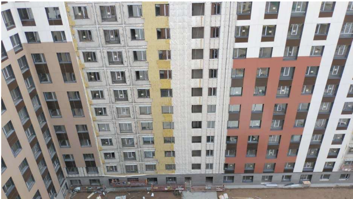
Рис. 2. Конструкция фасада в объемно-блочной системе.
