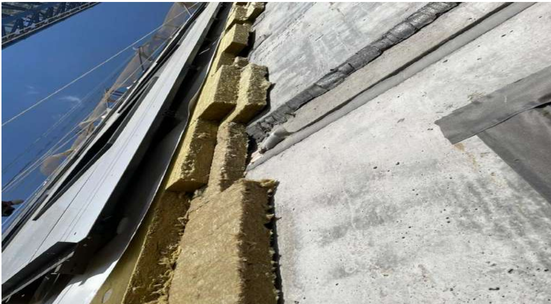
Рис. 1. Конструкция внешней стены.
